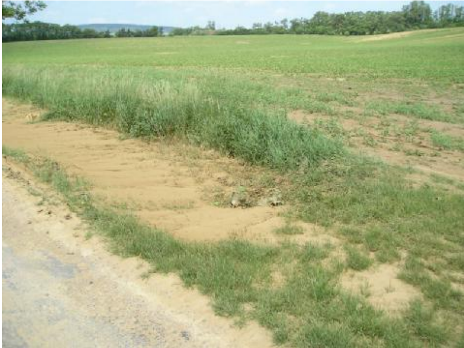
Obr. 13: Zanesený silniční příkop na úpatí svahu u Smržic, hloubka příkopu je až 50 cm
