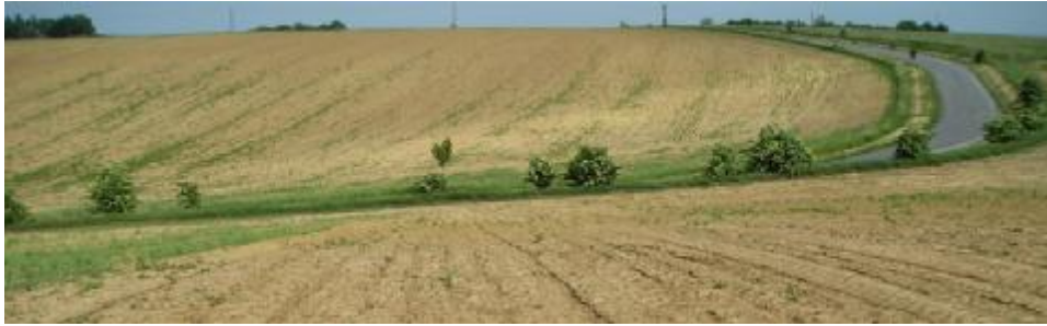
Obr. 4: Zatáčka silnice, kde bylo prováděno měření příkopů a okraje silnice totální stanicí. Označeno v příloze 1.
