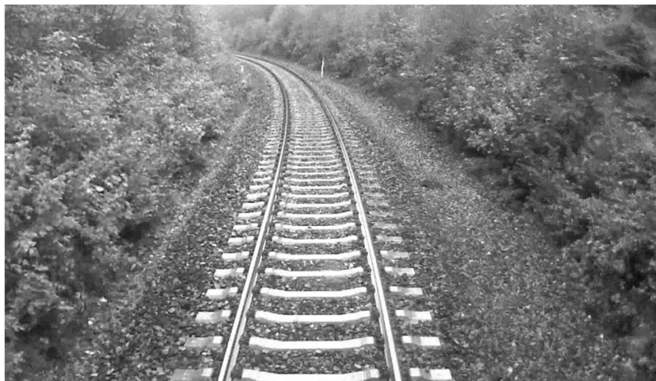
Obr. 19 Trať v úseku vykazujícím střední ohrožení přilehlou vegetací (převzato SŽ, 2020)
